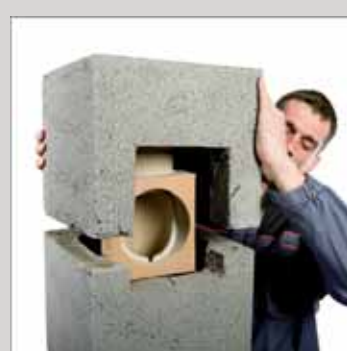
17. Osadzić pustak z wyciętym otworem na przyłączy spalin
