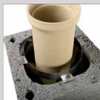
7. Osunąć opaskę dystansową do górnej powierzchni pustaka
