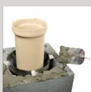
14. Nałożyć zaprawę murarską na pustak przykrywając jednocześnie zewnętrzne ramiona opaski
