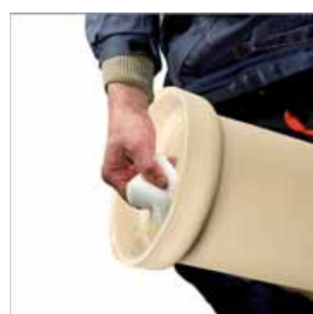
6. Oczyszczyć wilgotną gąbką wnętrze kielicha rury ceramicznej
