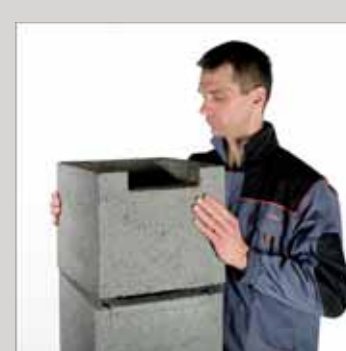
15. Osadzić następny pustak na zaprawie
