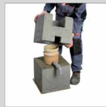
3. Osadzić pustak z wyciętymi otworami i rurkę do odpływu kondensatu i zewnętrzne drzwiczki czyszczaka
