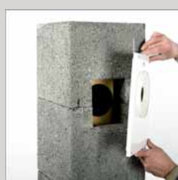
20. Ustawić centrycznie płytę przyłączeniową LAS
