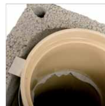
8. Osadzić rurę ceramiczną, tak aby nadmiar kitu został wyciśnięty
