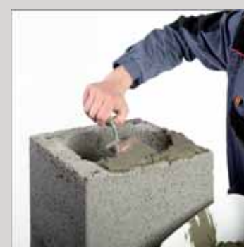
9. Nałożyć zaprawę murarską
