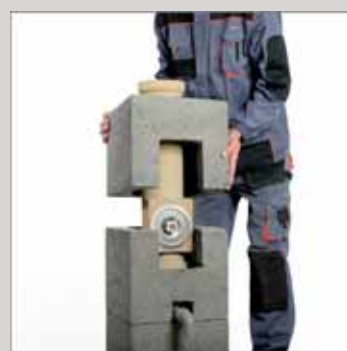
5. Osadzić następny pustak na zaprawie
