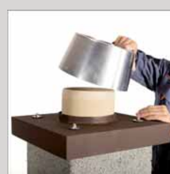
27. Założyć osłonę wylotu komina
