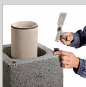
23. W otwory w narożnikach ostatniego pustaka obudowy wbić kołki rozporowe zestawu do montowania płyty przykrywającej
