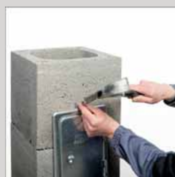
8. Przed tynkowaniem zewnętrzne drzwiczki czyszczaka zamontować za pomocą gwoździ „papiaków”
