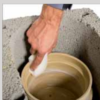
4. Kielich miski odpływu kondensatu przetrzeć mokrą gąbką
