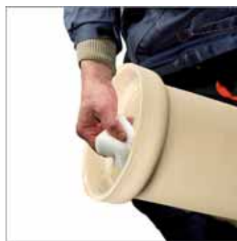
6. Oczyszczyć wilgotną gąbką wewnątrz kielicha rury ceramicznej
