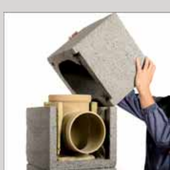
24. Ustawić kolejny pustak obudowy
