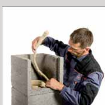
20. Kielich izolować sznurem lub paskiem z wełny mineralnej
