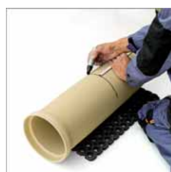
Cięcie rury ceramicznej - wyznaczenie miejsca przecięcia
