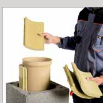
12. Montować kolejne elementy, łupki w razie potrzeby dociąć do wysokości kielicha
