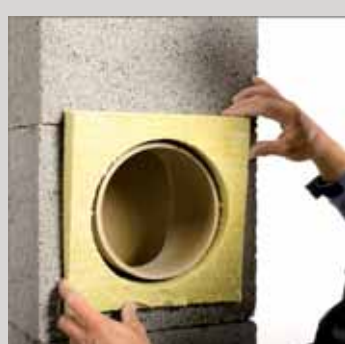
25. W wycięty w pustaku otwór wstawić płytę czołową z wełny mineralnej
