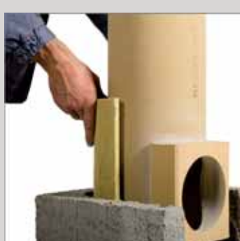
8. Przy otworze czyszczaka elementy z wełny mineralnej należy dociąć
