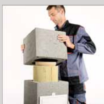
15. Montować na zaprawie następne pustaki obudowy kominia
