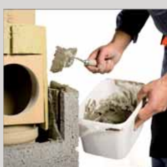
9. Nałożyć zaprawę murarską na ścianki pustaka
