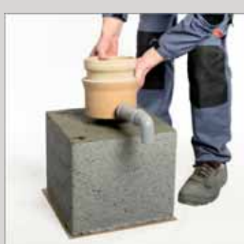
2. Umieścić na cokole pierwszy element ceramiczny: miskę odpływu kondensatu
