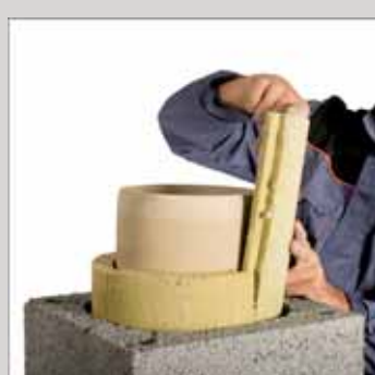
27. Montować kolejne elementy - łupki z wełny mineralnej
