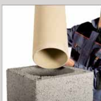
26. Montować kolejne elementy - rury ceramiczne
