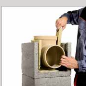
23. Podłączenie pieca starannie zaizolować docinając elementy z wełny mineralnej
