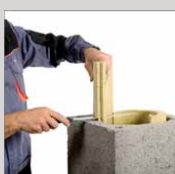
19. Elementy wełny mineralnej należy docinać, tak aby dochodziły tylko do kielicha rury ceramicznej
