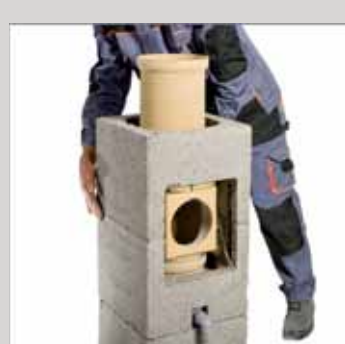
10. Ustawić następny pustak z wycięciem w drzwiczki zewnętrzne
