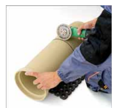
Rurę najwygodniej tnij się małą szlifierką kątową z tarczą diamentową
