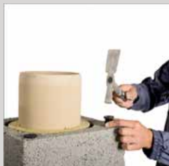
28. W otwory w narożnikach pustaka wbić dyble do montażu płyty przykrywającej
