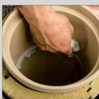
18. Nadmiar kitu usunąć gąbką namoczoną w wodzie
