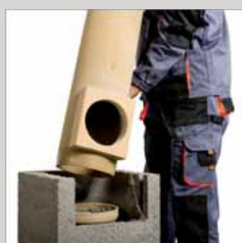
6. Wstawić czyszczak, wytrzeć nadmiar kitu, przez otwór czyszczaka, dla ochrony miski kondensatu włożyć kawałek folii lub papieru
