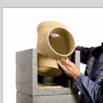
22. Po ustawieniu pustaka z wyciętym otworem ustawić element podłączenia pieca
