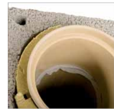
8. Osadzić rurę ceramiczną, tak aby nadmiar kitu został wycisnięty
